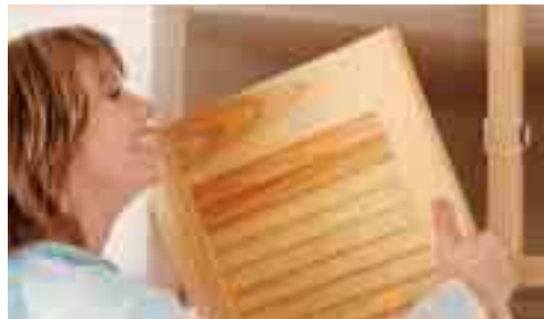
Sind die Trägerleisten an der Wand befestigt (großes Bild), werden die Nut- und Federbretter darauf angebracht (links). Den Abschluss bilden Lamellentüren mit Magnetverschlüssen
